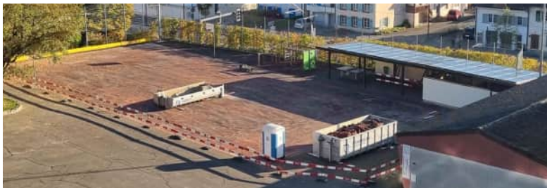
Abgefräster Belag
