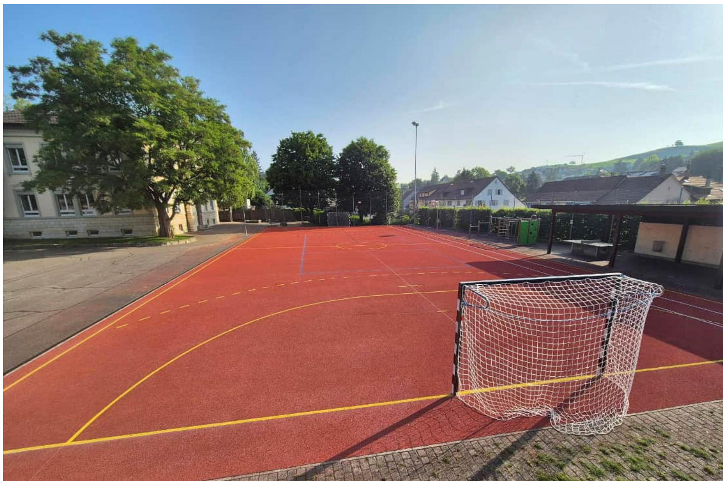
Fertiggestellter Sportplatz, neue Markierungen und Tore
